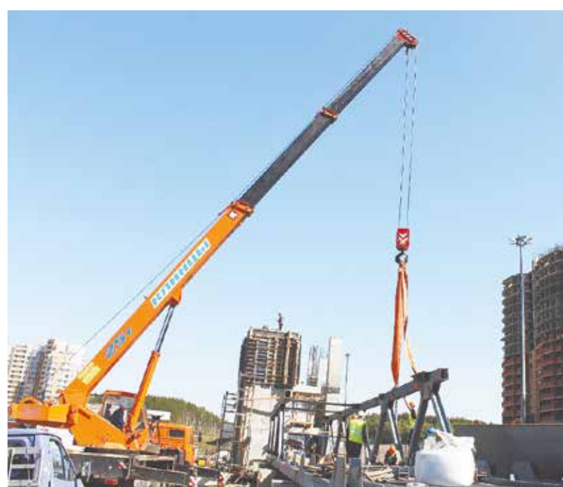
Продолжается строительство надземного пешеходного перехода над Старосимферопольским шоссе (участок 43-48 км) в районе ЖК «Весенний» и ЖК «Бородино»
