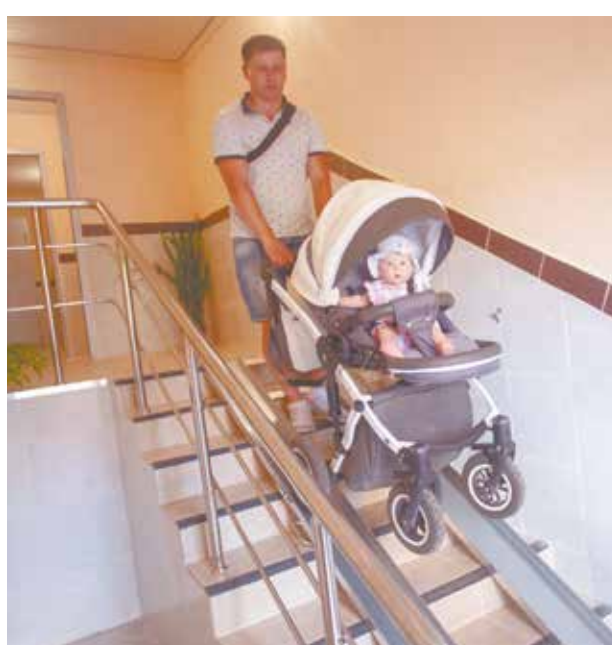
По программе «Формирование современной комфортной городской среды» на 2018-2022 годы в округе по плану 2019 года уже отремонтировано 505 подъездов из 900 запланированных
