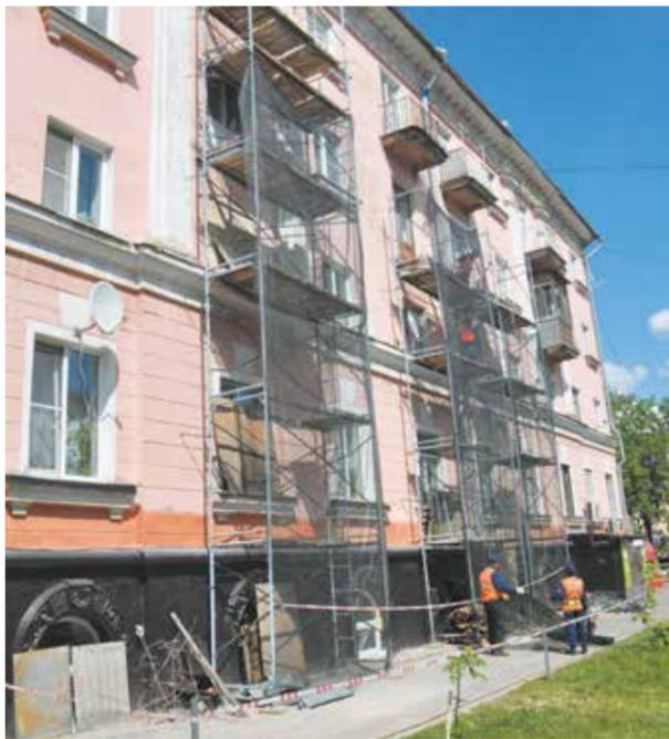
здания, заменить балконные плиты, установить пластиковые окна в местах общего пользования (в подвальной и подъездной частях) и входные металлические двери с утеплением, отремонтировать козырьки над подъездами.
