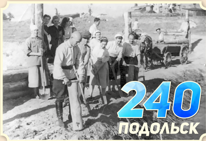
Климовчане на строительстве плотины через Петрицу, 1940-е
